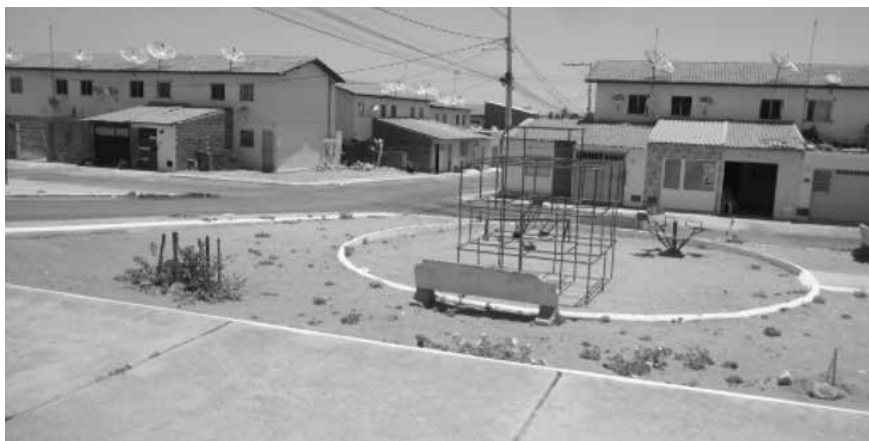
Figura 01 – Imagem do Conjunto Habitacional na cidade de Paulo Afonso/BA.
